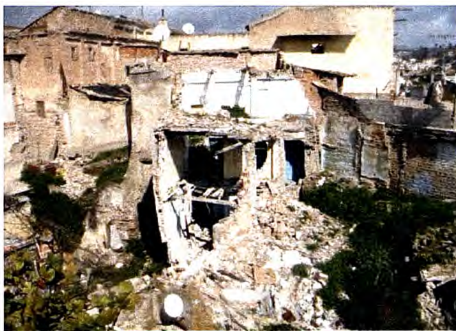
Les constructions en ruine : basse Souika (la médina)
