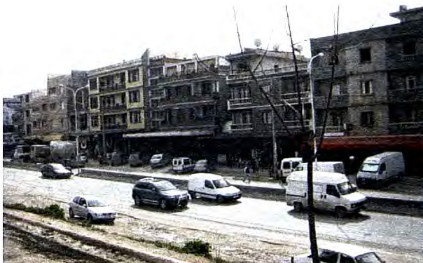
Photo n° 2 : Alignement de l'habitat illégal tout le long de la route nationale n°3.
