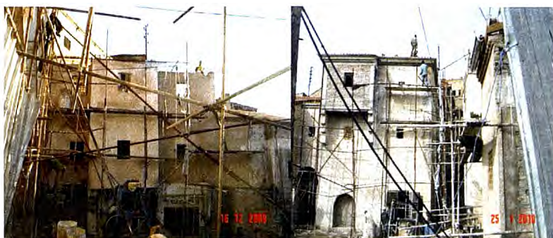
Bab El Djebia : au cours des travaux de réhabilitation de la place et la restauration
