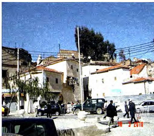
Bab El Djebia : après l'achèvement des travaux de réhabilitation et de restauration (2010)
