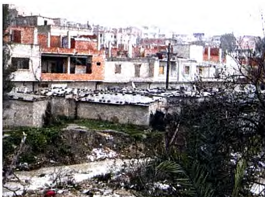
Photo n°1 : Vue ouest du quartier, une dégradation de l'habitat illicite en dur et bidonvilles sur la rive d'oued Boulbraghet.
