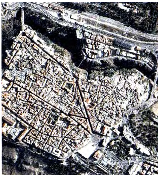
Une vue aérienne du centre historique (le rocher) en 1980
