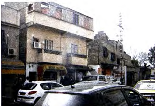
Photo n°1 : Rue principale (CW 133) Habitat informel en dur alignement du commerce tout le long de cet axe à grande circulation
