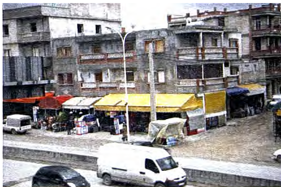
Photo n°3 : Coté ouest , alignement des commerces tout au long des RDC des habitations
