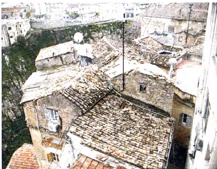
Les constructions dégradées : basse Souika (la médina)
