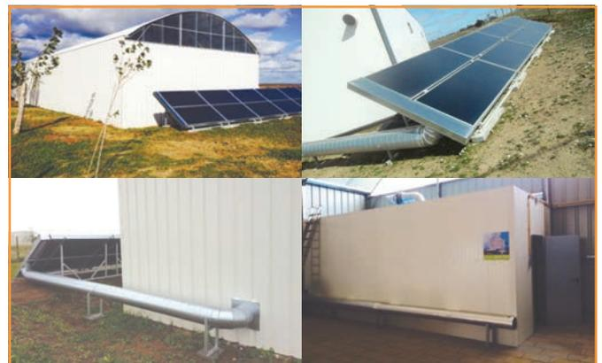
Figure 1: Séchoir industriel avec capteurs non intégrés (2)
