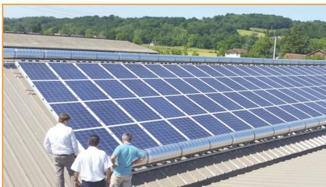
Figure 5: Séchoir PVT implanté sur le toit d'un hangar (3)
