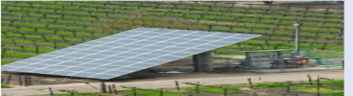
Figure 1 : Les applications de l'énergie solaire photovoltaïque dans les activités hydro-agricoles (Ain Taorout- Bordj bou Arredj).
