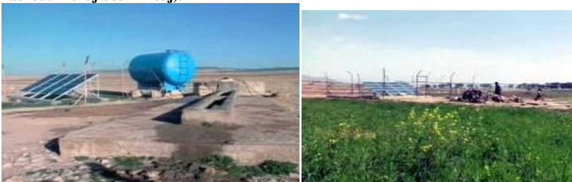
Figure 01 :Utilisation du système d'énergie solaire pour l'irrigation Ras El Oued - Willaya Bourdj Bou Arredj.
