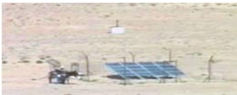
Figure 02 : Projet réalisé du système d'énergie solaire (phytovoltaïque) pour l'irrigation et l'élevage des bovins Ain Tarout - Willaya Bourdj Bou Arredj.
